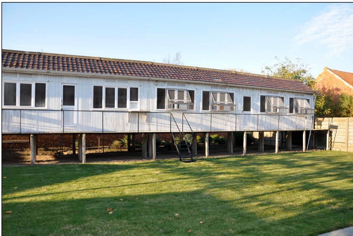
Slaganläggningen hos Monick Nys – Arendonk
